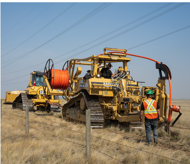
EIDNet Phase 1 Fibre Conduit Installation.
